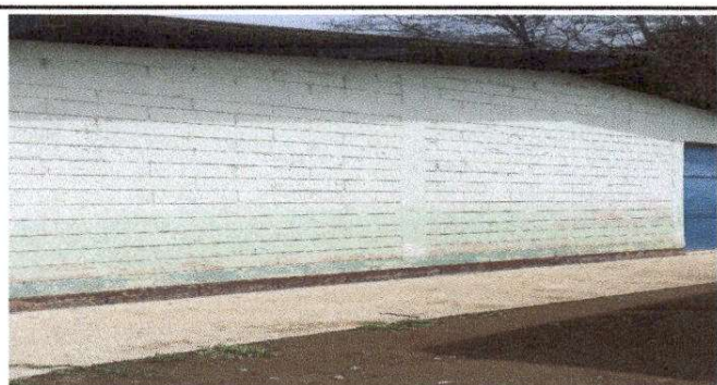
Foto 5: Pintura en muros exteriores e interiores
