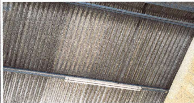
Foto 8: Sustitución de lámparas tipo led
