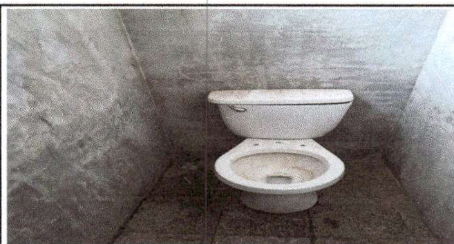
Foto 6: Sustrucción de accesorios de inodoro (contra llave, tubo de abasto y tanque)
