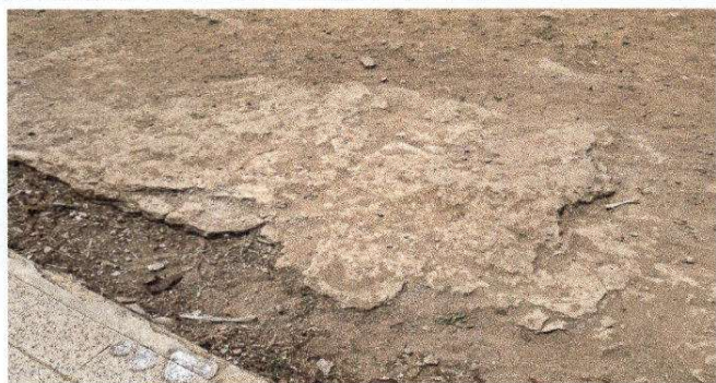
Foto 7: Reparación de planchas de concreto de patio
