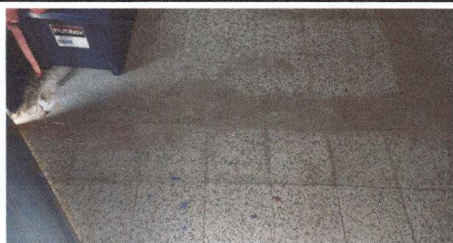
Foto 3: Sustrucción de piso cerámico
