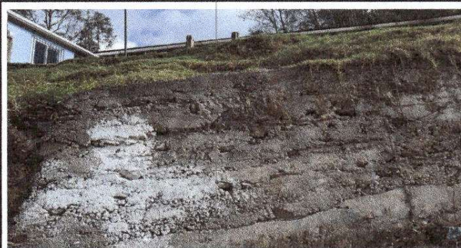
Foto 10: Reparación de muro de contención
