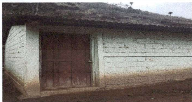
Foto 1: Sustrucción de puerta
