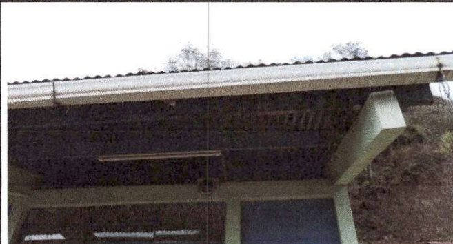
Foto 4: Sustrucción de canal de PVC
